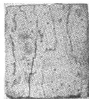
(b) 二级配混凝土
